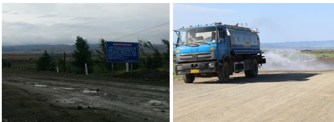
图 7.1-1 施工现场采取洒水降尘措施
