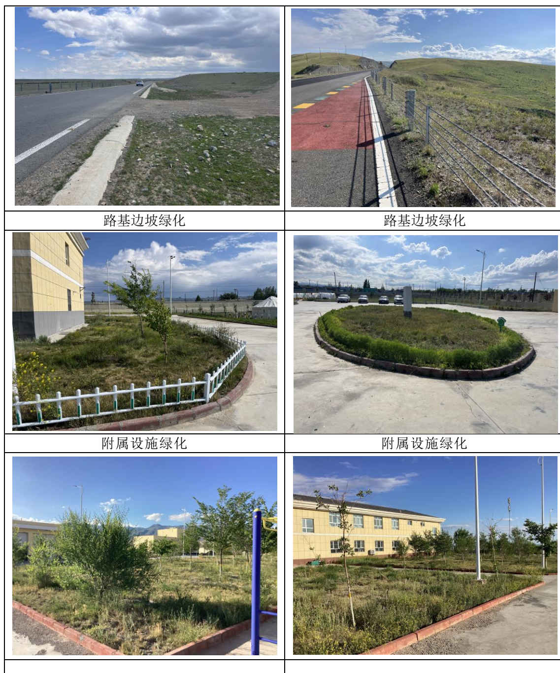
图 5.6-1 沿线路基边坡附属设施绿化工程现状
