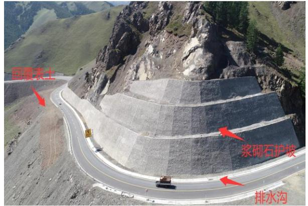
图4.1-4 路基工程排水、防护、土地平整
