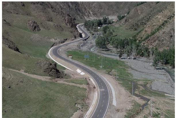
图4.1-14 路基排水沟及浆砌护坡
