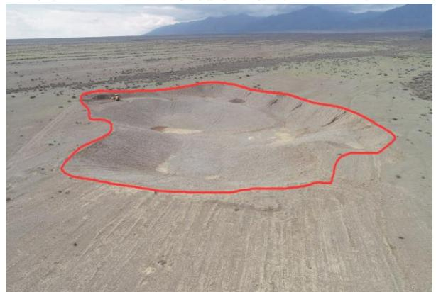
图4.1-6 取(弃)土料场削坡、土地平整
