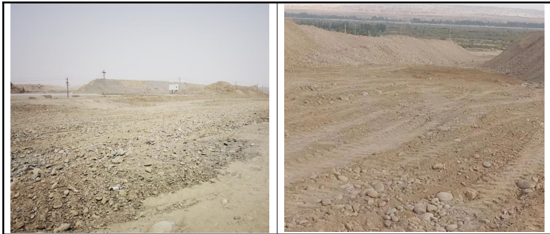
图3.3-1取土场（兼弃土场）照片
