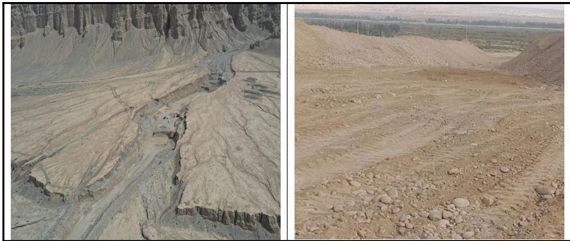
图3.2-1 K75+200取土场（兼弃土场）照片
