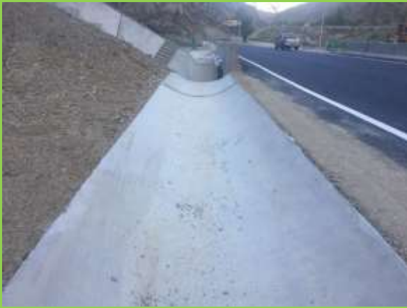
现浇混凝土边沟
