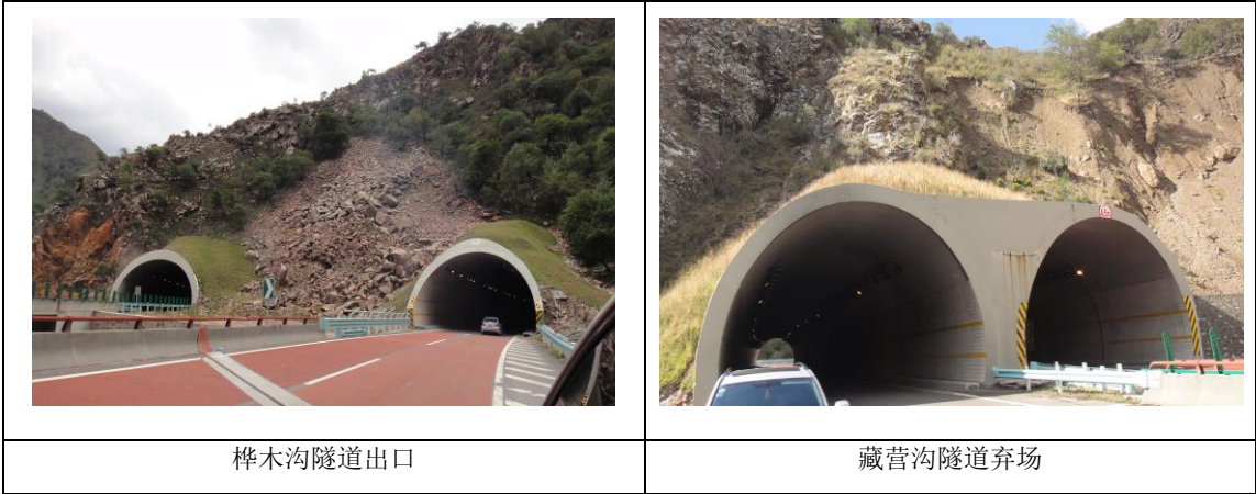
图 5-3-2 弃土场现场照片
