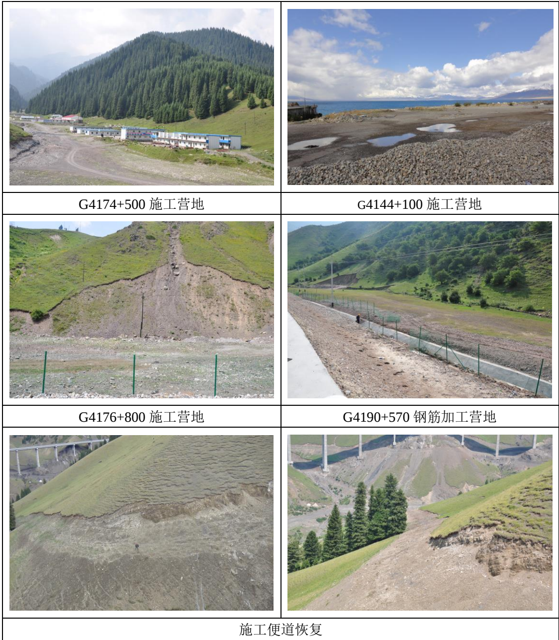
图 5-3-3 其它临时占地现场照片
