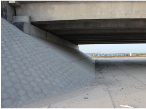
实心六棱块护坡（C25 水泥混凝土）
