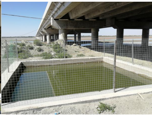
叶尔羌河特大桥径流收集沉淀池
