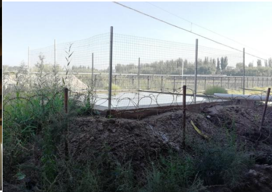
小亚郎水库大桥径流收集沉淀池
