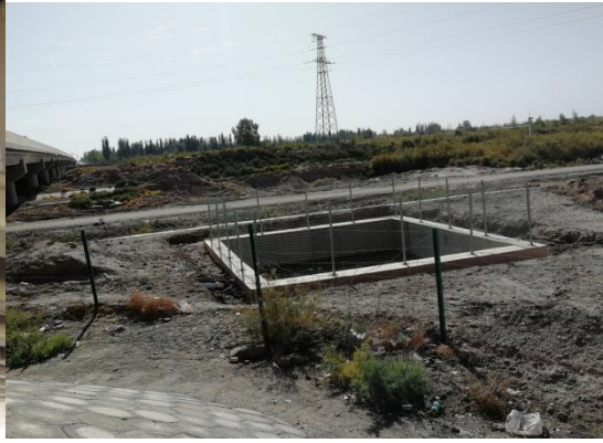
小亚郎水库大桥径流收集沉淀池
