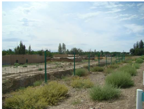
路基边坡植草防护
