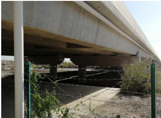
克孜勒河大桥桥面径流收集管道
