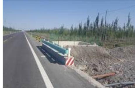
K2921+181 塔米十一桥防渗事故水收集池
