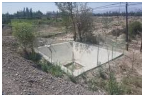
K2902+847 乔木伦桥防渗事故水收集池
