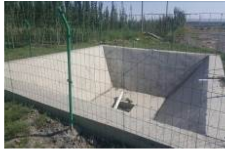
K2921+810 克力干一桥防渗事故水收集池
