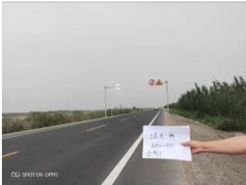
塔米一桥 (K2910+937) 警示牌
