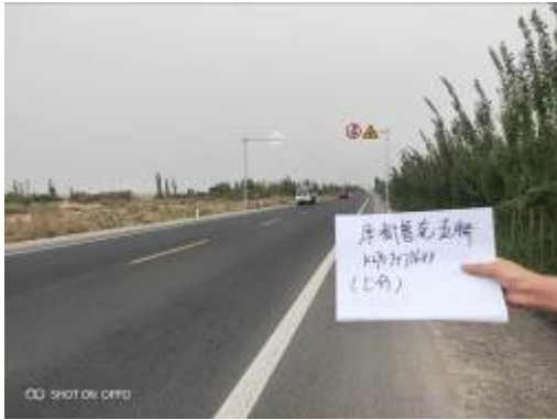
库都鲁克五桥 (K2909+796) 警示牌
