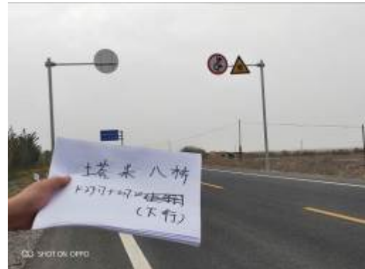
塔米八桥 (K2917+027) 警示牌
