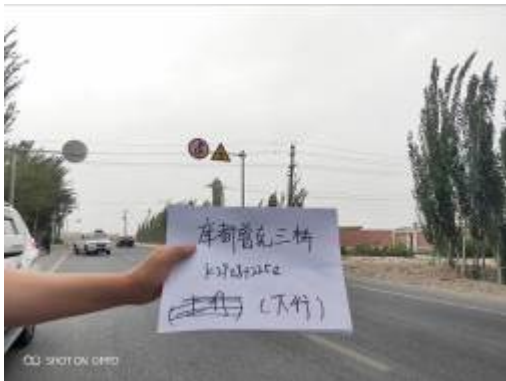
库都鲁克三桥 (K2908+225) 警示牌
