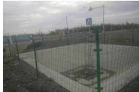
K2922+051 克力干二桥防渗事故水收集池
