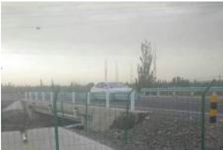
K2922+051 克力干二桥桥面径流水收集系统
