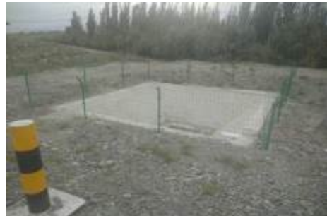
K2924+111 加依一桥防渗事故水收集池
