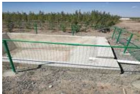
K2887+898 马牙克七桥防渗事故水收集池
