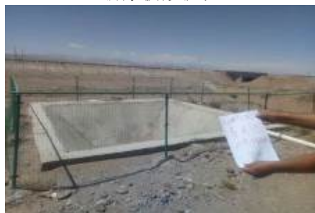
K2867+757 小桥防渗事故水收集池
