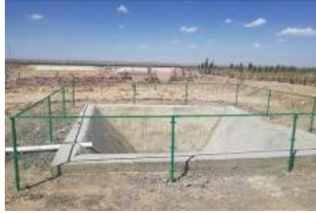
K2881+754 马牙克二桥防渗事故水收集池
