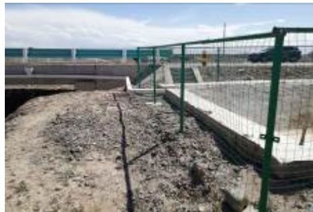
K2887+309 马牙克六桥防渗事故水收集池
