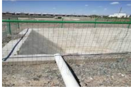
K2885+314 马牙克四桥防渗事故水收集池
