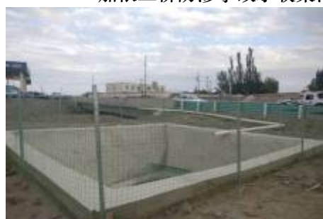
K2941+028 萨罕水库主泄洪道中桥防渗事故水收集池
