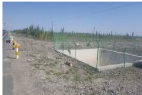
K2919+043 塔米九桥防渗事故水收集池
