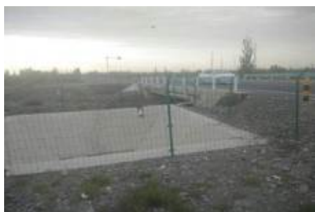
K2925+777 加依二桥桥面径流水收集系统
