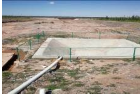
K2896+481 马牙克十三桥防渗事故水收集池
