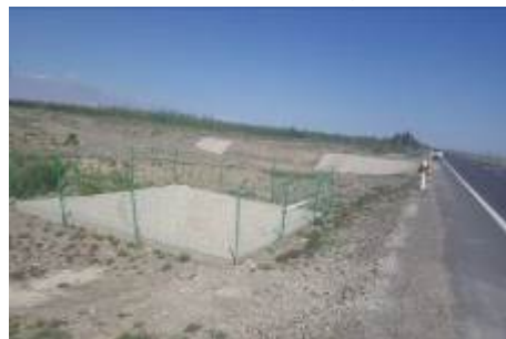
K2915+069 塔米六桥防渗事故水收集池
