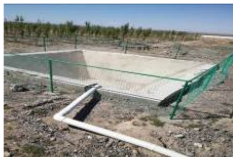
K2886+181 马牙克五桥防渗事故水收集池
