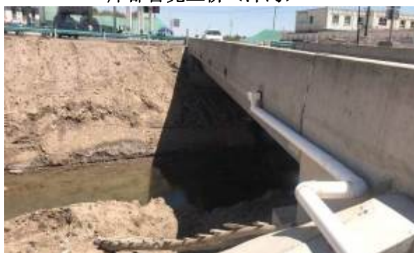
萨罕水库主泄洪道中桥 (泄洪水渠)
