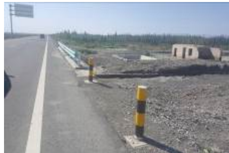
K2917+027 塔米八桥防渗事故水收集池
