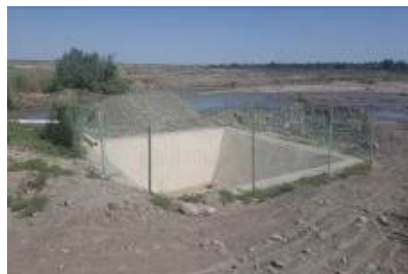
K2910+402 库都鲁克六桥防渗事故水收集池
