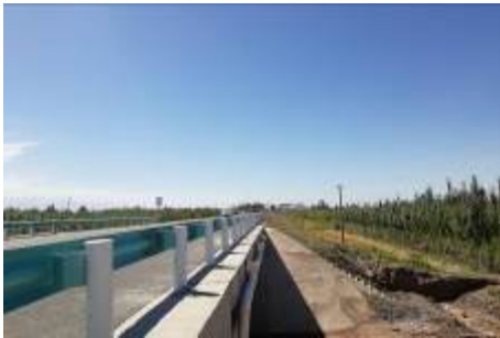
K2897+291 马牙克十四桥桥面径流水收集系统
