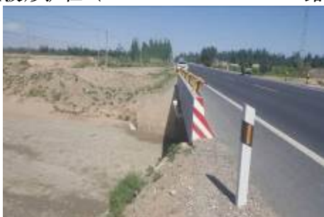
桥梁墙式混凝土防撞护栏
