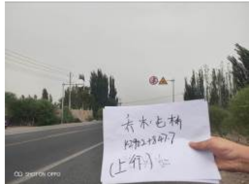
乔木伦桥 (K2902+847) 警示牌
