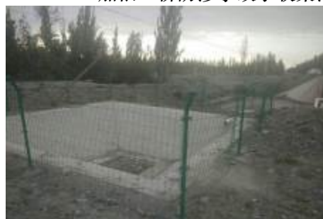
K2927+182 加依三桥防渗事故水收集池
