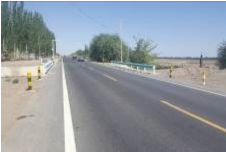
K2908+225 库都鲁克三桥桥面径流水收集系统
