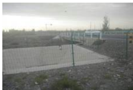
K2925+777 加依二桥防渗事故水收集池
