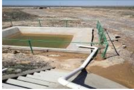
K2891+969 马牙克十一桥防渗事故水收集池
