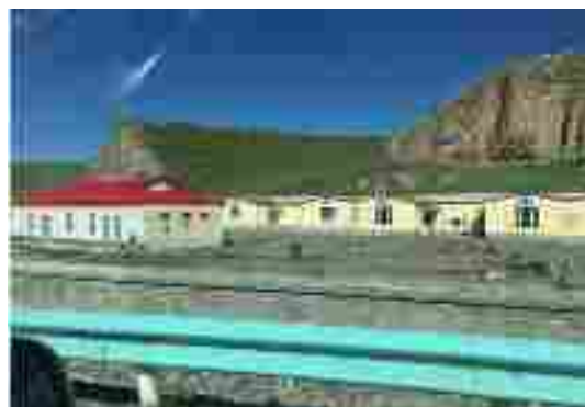
山口大桥那里的施工驻地
