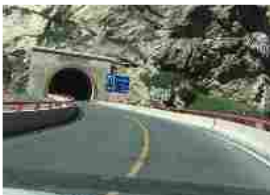
呼屯郭楞隧道（K922）
