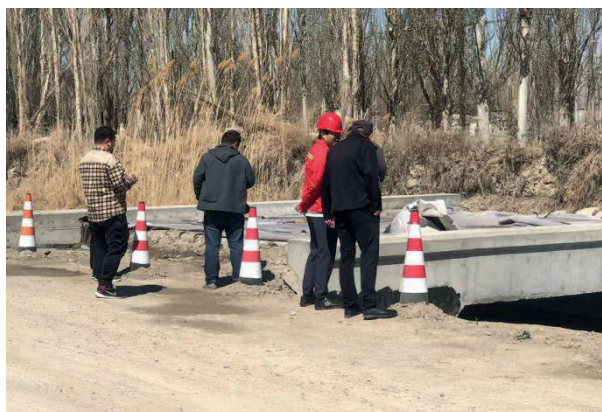
图1.3-11 桥涵工程调查检测
