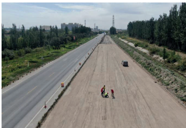
图1.3-12 路基工程调查检测
