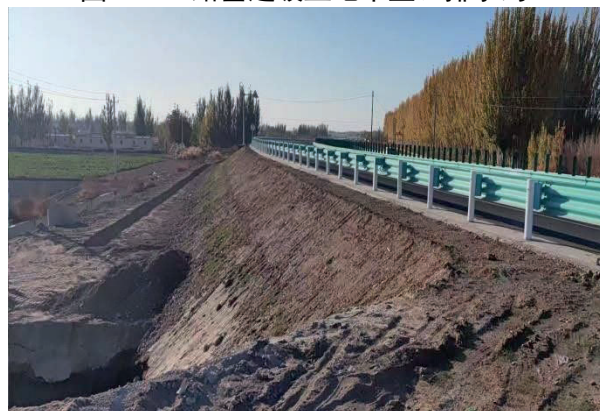
图4.1-12 路基边坡土地平整、排水沟
