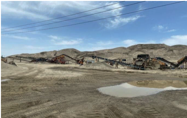
图3.3-2 商购料场厂区
