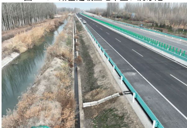
图4.1-9 路基边坡土地平整、排水沟
