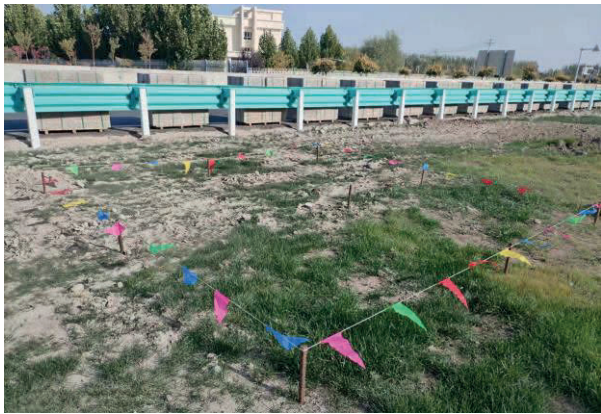
图1.3-8 路基边坡测钎法
