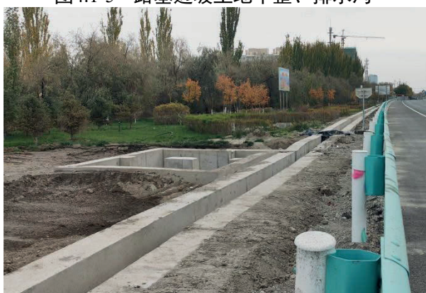
图4.1-7 路基边坡土地平整、沉砂池
