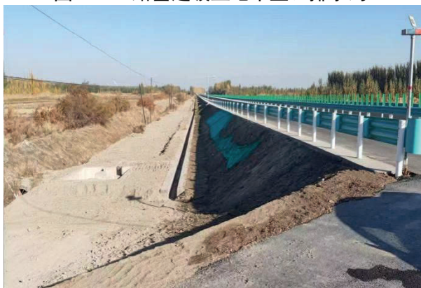
图4.1-11 路基边坡土地平整、排水沟
