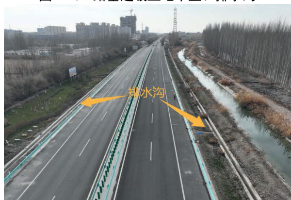
图4.1-10 路基边坡土地平整、排水沟
