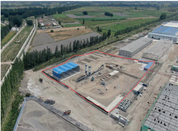
图3.5-1 K7+800综合场站
