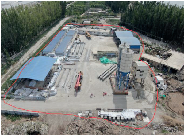
图3.5-2 K7+900综合场站
