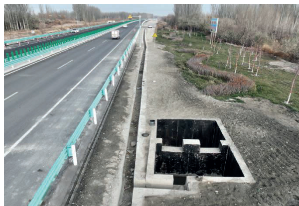
图4.1-6 路基边坡土地平整、排水沟
