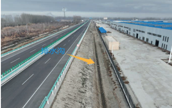
图3.1-8 路基排水沟2024年11月
