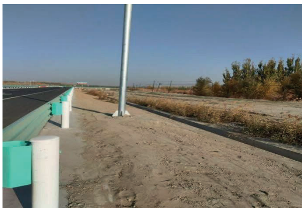
图4.1-5 路基边坡土地平整、排水沟
