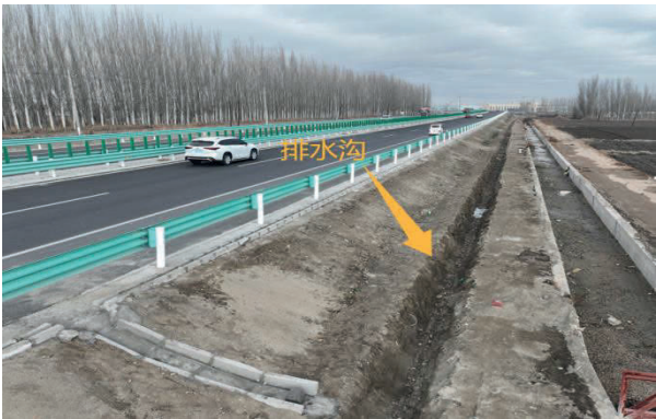
图3.1-5 K8+800排水沟2024年11月
