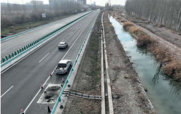
图3.1-7 K14+000排水沟及急流槽2024年11月
