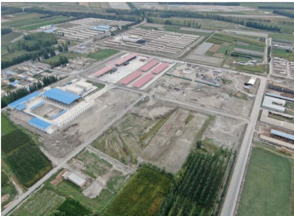
图3.4-1 K9+420弃土（渣）场现状
