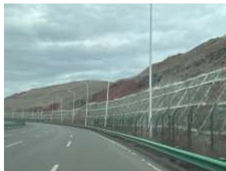
框架锚杆护坡
