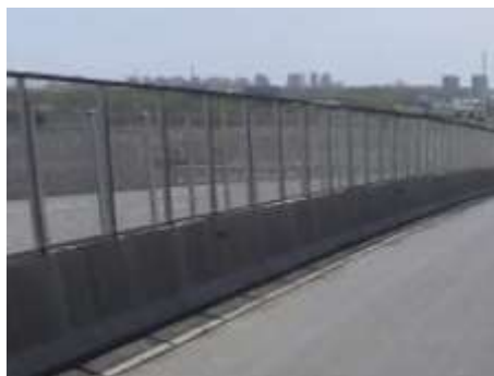
跨水磨河桥梁防撞护栏及防抛网
