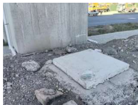
高架桥下收集收集池
