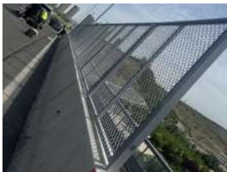
跨和平渠桥梁防撞护栏及防抛网
