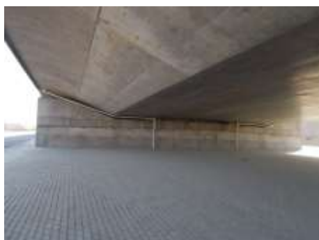
高架桥径流收集系统
