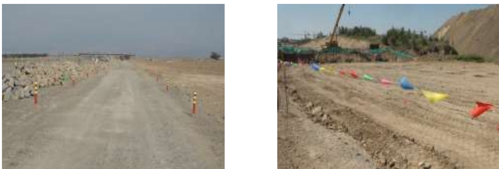
图 5.4-1 本项目施工现场红线标志照片
