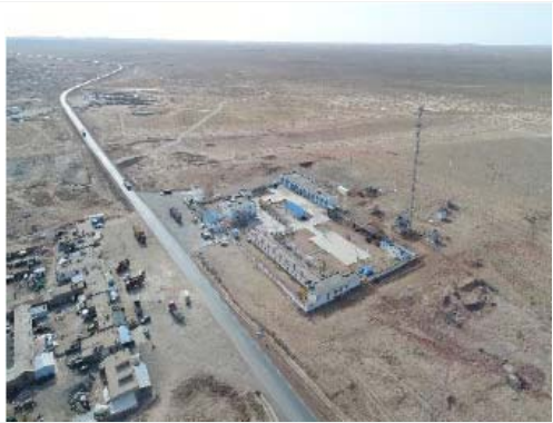
租用喀木斯特镇养护站项目部 图 6.3 施工全过程施工场地照片（续）
