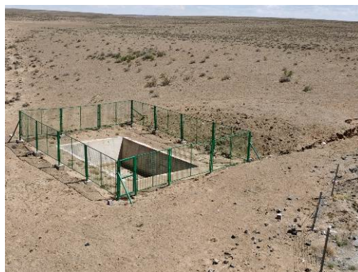
事故水收集池
