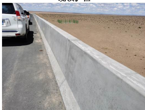
钢筋混凝土墙式护栏
