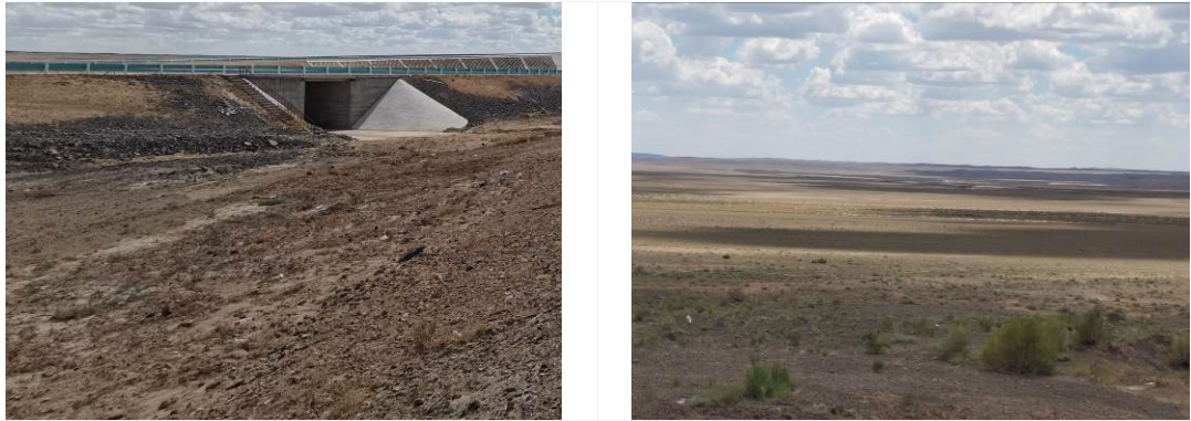
图 6.4 施工便道恢复照片
