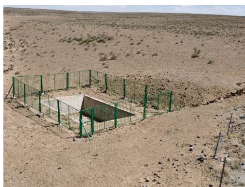
事故水收集池
