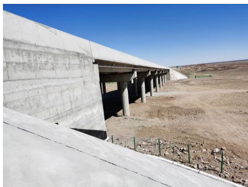
桥头混凝土护坡
