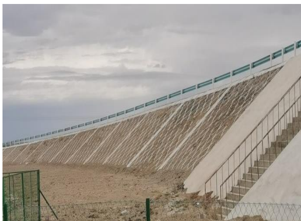
图 4.1-3 方格网护坡及土地平整
