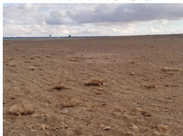
图 4.1-7 施工场站恢复及土地平整
