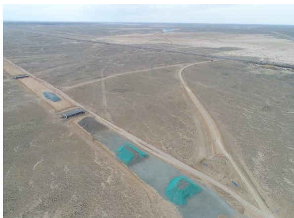
图 4.3-1 路基防尘网苫盖
