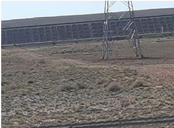
图 4.2-2 施工便道撒播草籽 2
