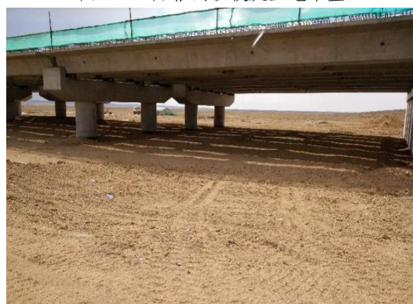
图 4.1-5 桥梁施工迹地土地平整
