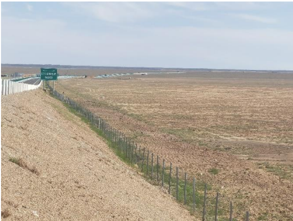
图 4.2-1 施工便道撒播草籽 1
