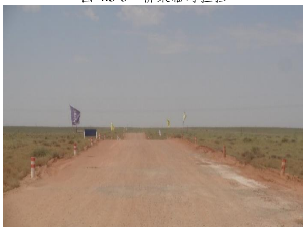
图 4.3-5 施工便道限制性环保桩及彩旗
