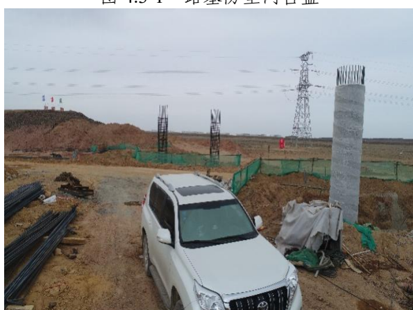
图 4.3-3 桥梁临时拦挡
