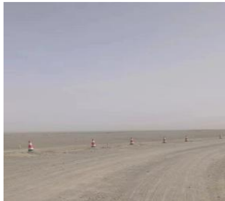
施工便道限行桩
