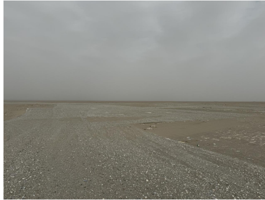
施工生产生活区恢复情况
