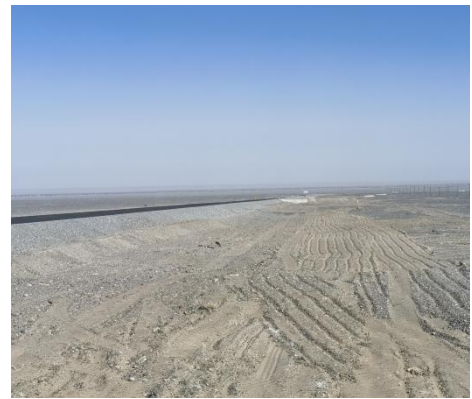
施工便道恢复情况
