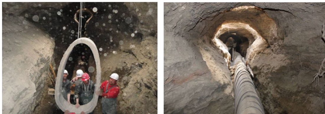
坎儿井暗渠加固
