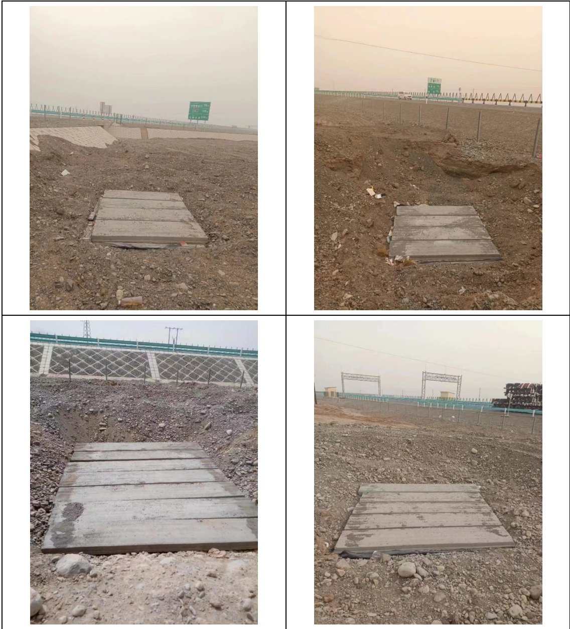
主线坎儿井竖井井口加盖和防渗
