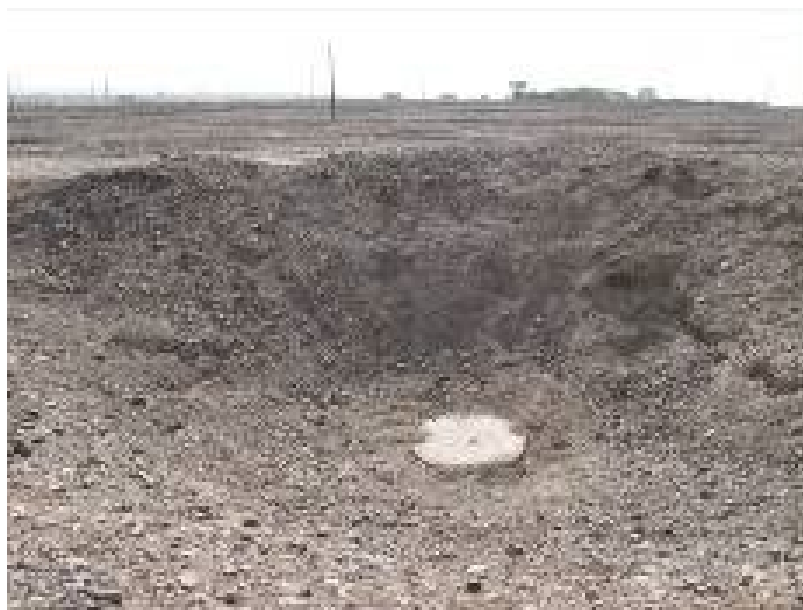
连接线坎儿井井口加盖和防渗
