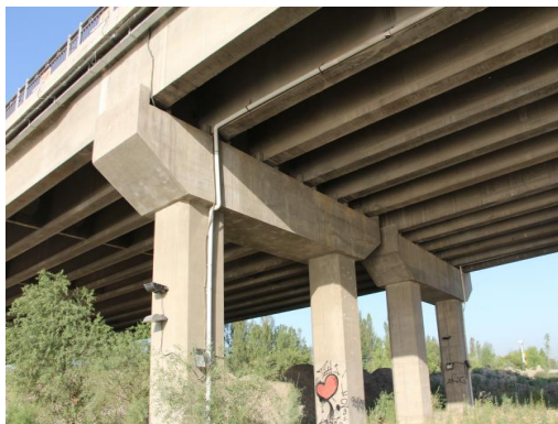
伊犁河大桥桥面径流收集管线
