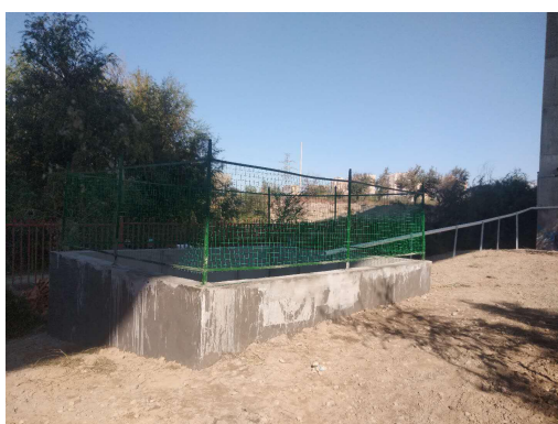
伊犁河大桥桥面径流收集系统桥梁两侧事故池
