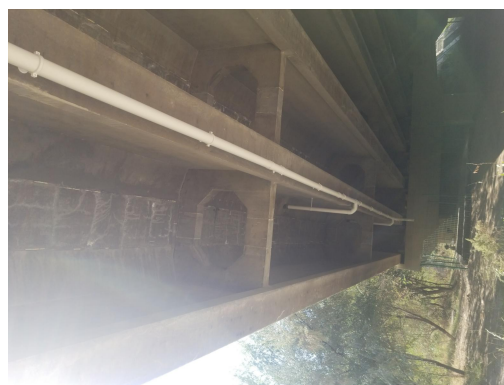
伊犁河大桥桥面径流收集管线
