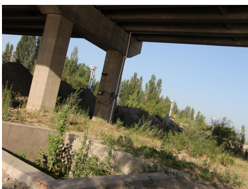
伊犁河大桥桥面径流收集系统桥梁两侧事故池
