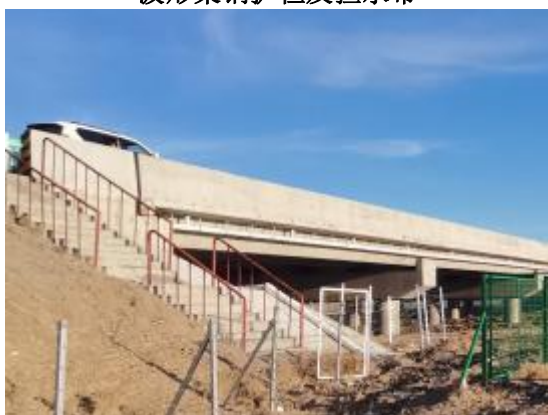
混凝土墙式护栏
