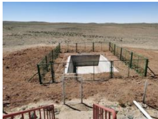
事故水收集池
