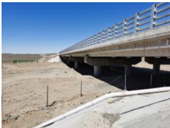
桥面径流收集系统 (1)
