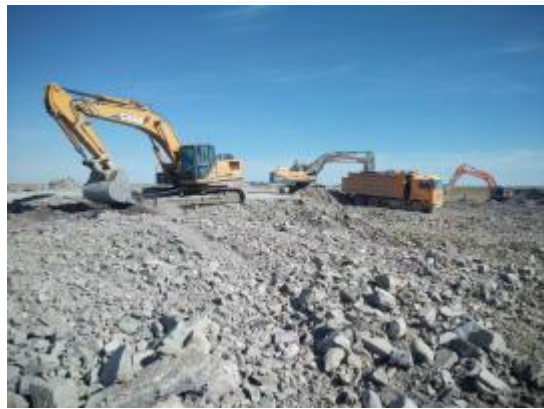
LK299+200 施工生产生活区使用照片
