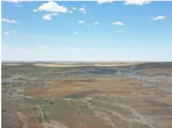
LK299+200 施工生产生活区恢复情况
