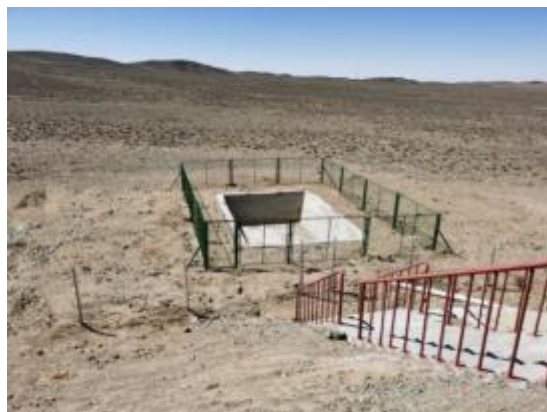
事故水收集池 (1)
