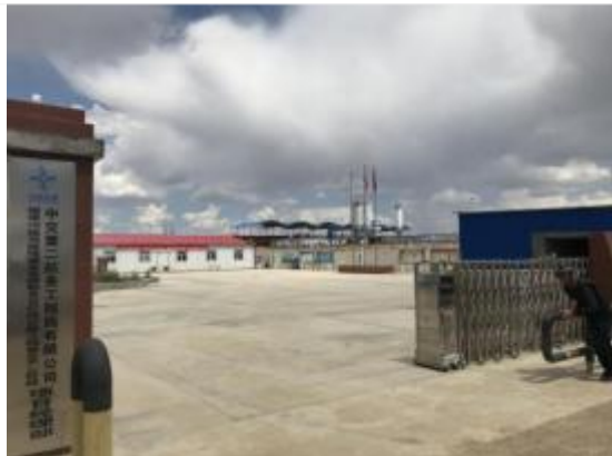
LK309+600 施工生产生活区使用照片
