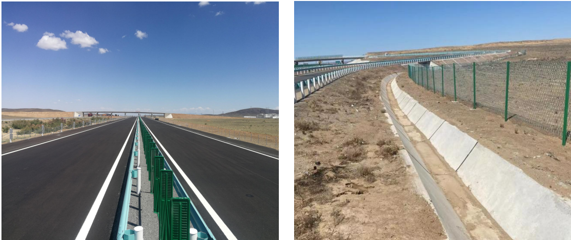
图 1-2 路基工程区现状
