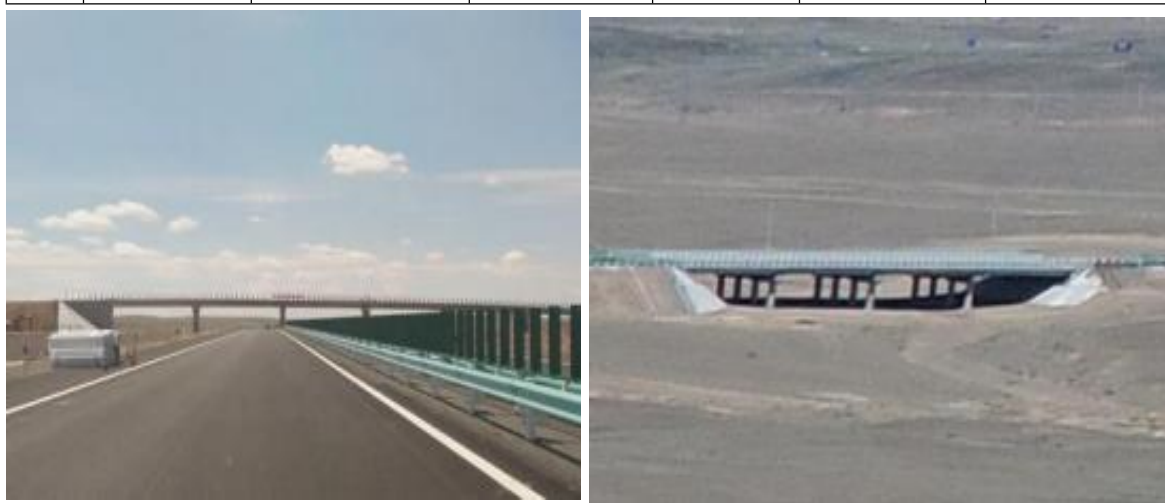
图 1-3 桥梁立交工程区现状
