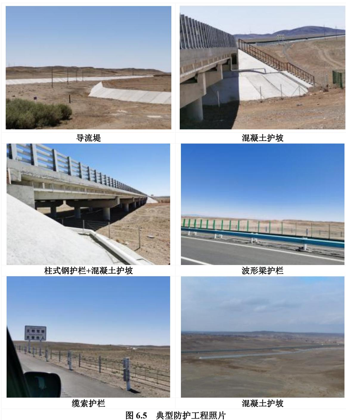
图 6.5 典型防护工程照片
