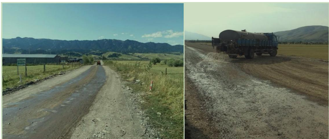
图 7.2-1 施工洒水照片
