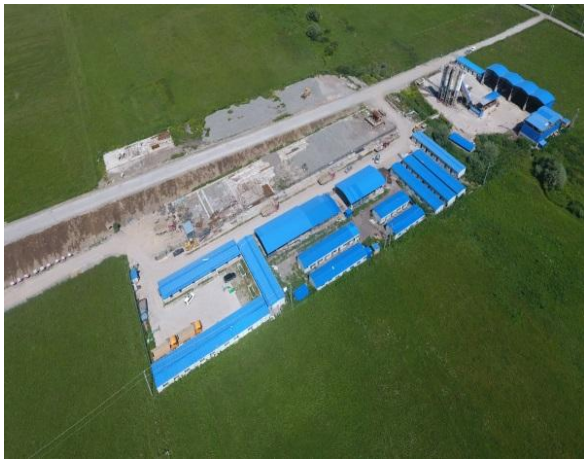
K314+860 拌合站、预制场恢复前影像
