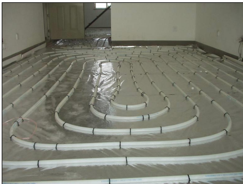
图 7-2-1 电缆采暖施工期照片
