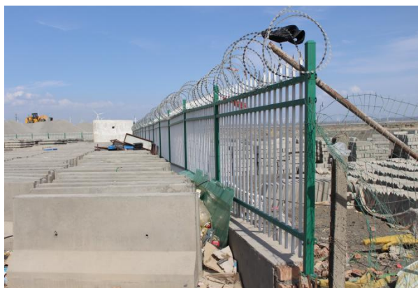
图 4.3-5 施工生产生活区铁丝网围挡
