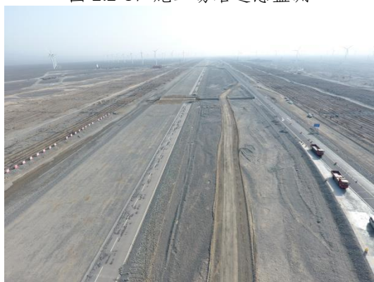
图 2.2-19 路基工程遥感监测
