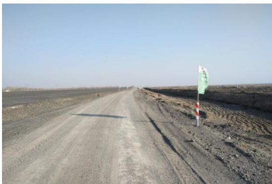
图 3.5-1 施工期-施工便道
