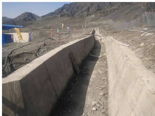
图4.1-10 隧道截排水工程
