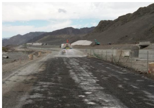
图 3.5-2 施工期-施工便道
