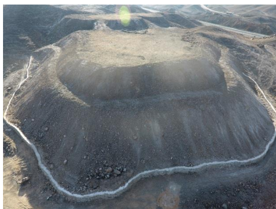
图 2.2-15 弃渣场遥感监测
