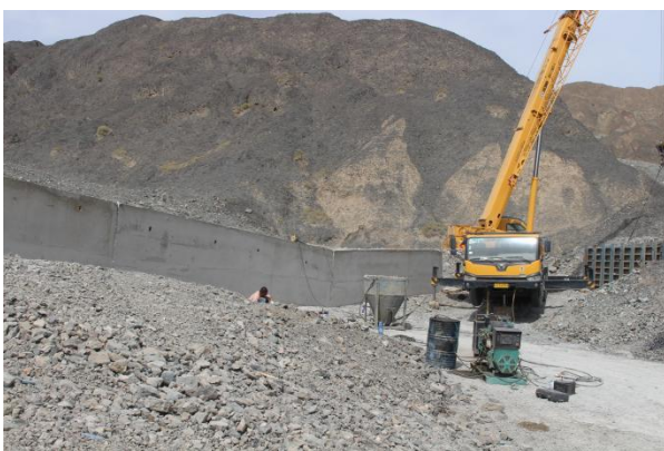
图4.1-14 弃渣场挡渣墙
