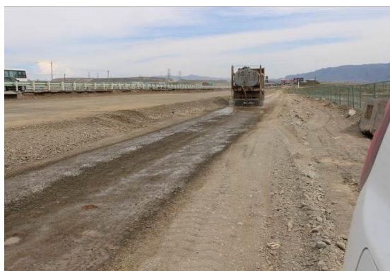
图 3.5-3 纵向施工便道
