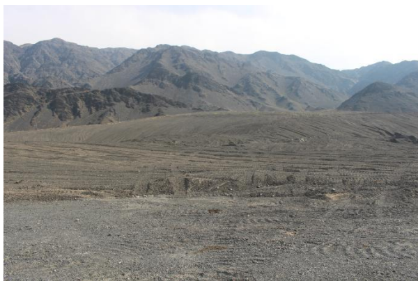
图4.1-11 取土场削坡
