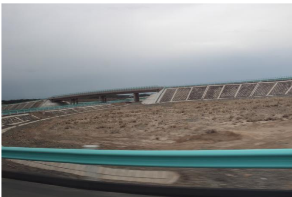
图4.1-8 互通工程区排水沟及菱形护坡
