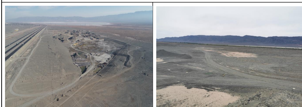
图 3.2-5 K3531+200 左侧 660m 取土场，已平整恢复，并移交（左：施工中；右：恢复后）
