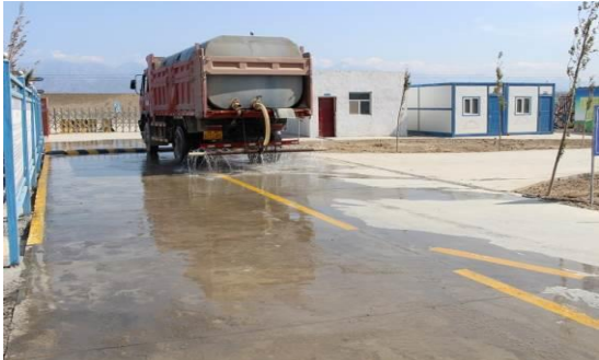
图 4.3-2 施工生产生活区洒水降尘
