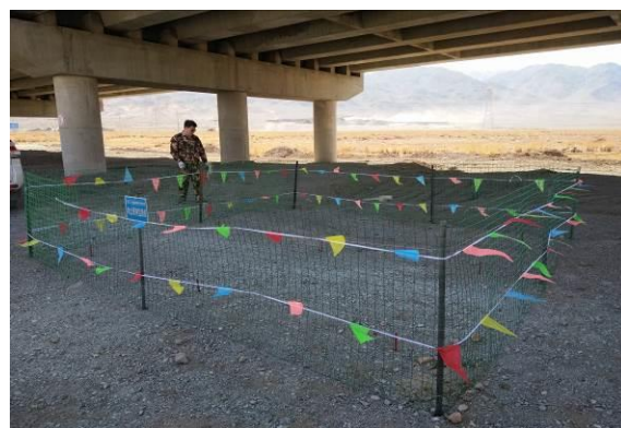
图 1.3-6 桥涵工程区监测点
