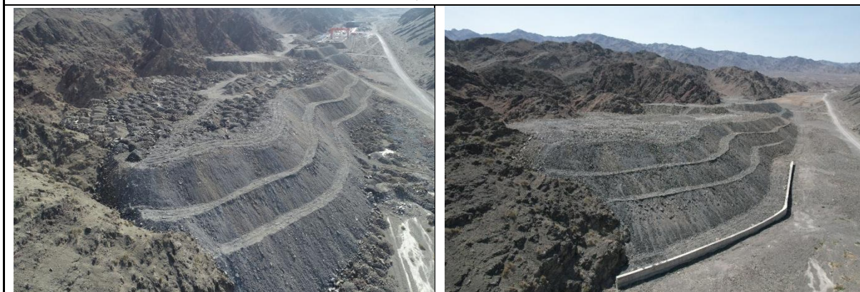
图 3.3-7 K3497+450 左侧 1000m 弃渣场，已采取土地平整、挡渣墙等措施（左：施工中；右：恢复后）
