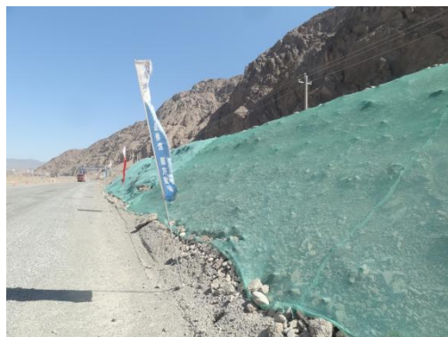
图 4.3-9 路基边坡防尘网苫盖
