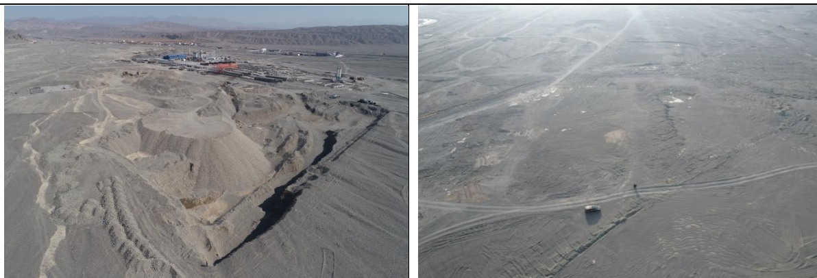
图 3.3-2 K3472+500 左侧 500m 弃渣场，取其结合，已平整恢复（左：施工中；右：恢复后）
