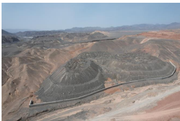
图4.1-7 弃渣场削坡分级、挡渣墙
