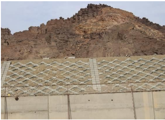
图4.1-1 路基边坡方格网防护
