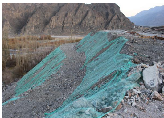
图 4.3-7 弃渣场防尘网苫盖
