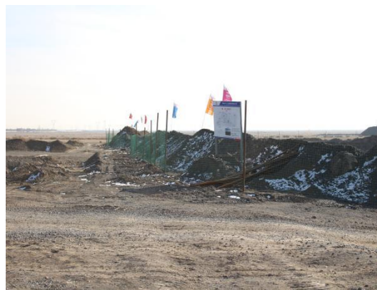
图 4.3-12 取土场铁丝网拦挡
