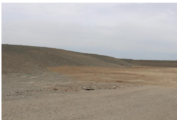
图4.1-13 取土场削坡、平整
