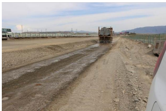
图 4.3-3 施工便道洒水降尘
