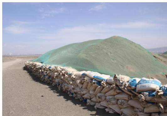
图 4.3-4 施工生产生活区装土编织袋拦挡及苫盖
