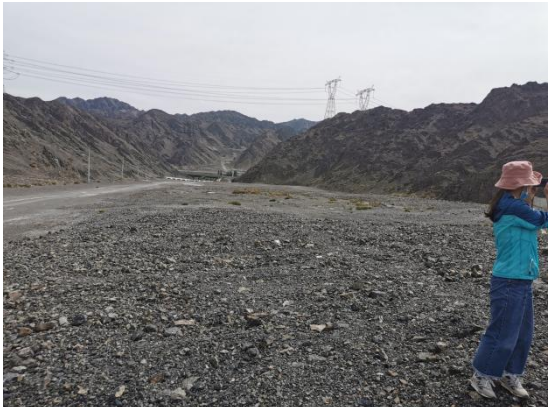
图4.1-16 施工便道土地平整
