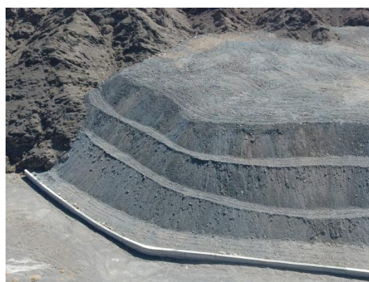
图 2.2-18 弃渣场遥感监测
