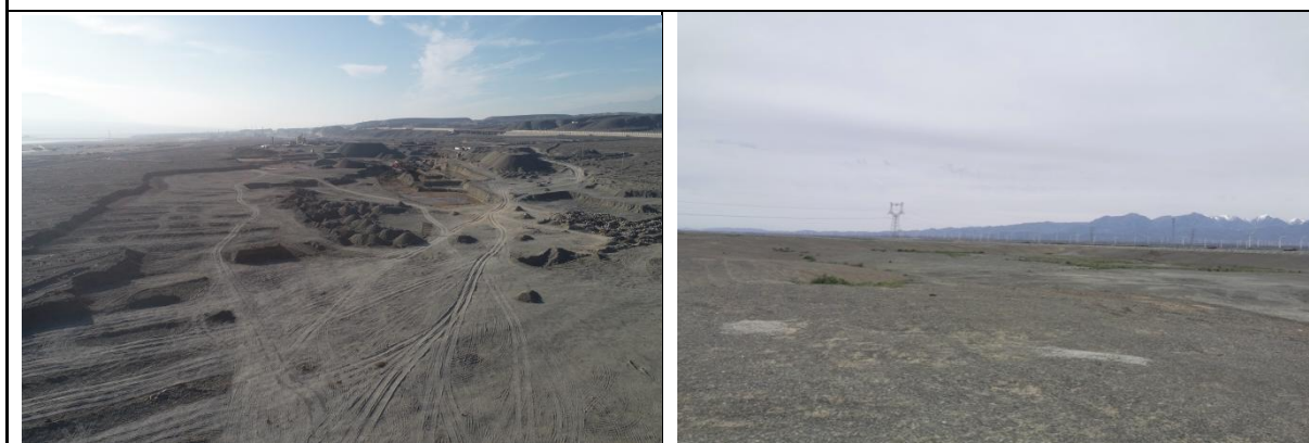
图 3.2-4 K3521+200 右侧 460m 取土场，已平整恢复，并移交（左：施工中；右：恢复后）
