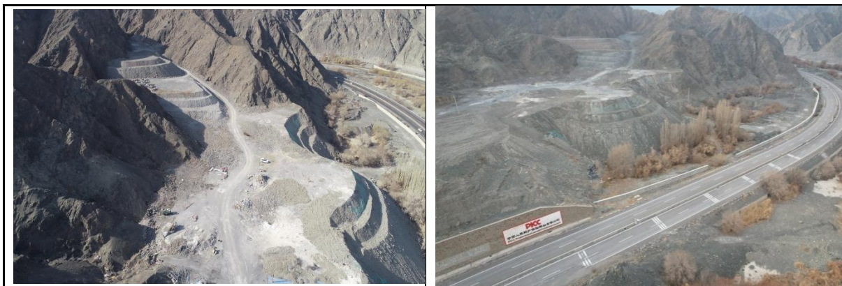
图 3.3-5 K3494+500 右侧 200m 弃渣场，已采取土地平整、挡渣墙等措施（左：施工中；右：恢复后）
