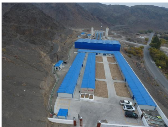
图 2.2-17 施工场站遥感监测
