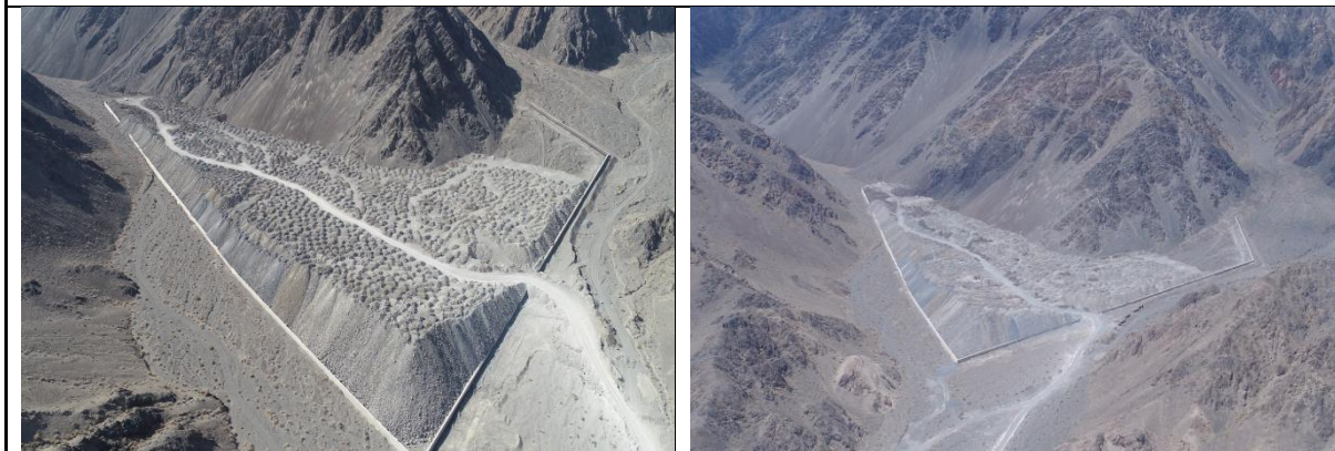
图 3.3-7 K3497+450 左侧 1000m 弃渣场，已采取土地平整、挡渣墙等措施（左：施工中；右：恢复后）
