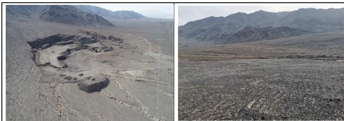
图 3.2-2 K3509+800 左侧 920m 取土场，已平整恢复，并移交（左：施工中；右：恢复后）
