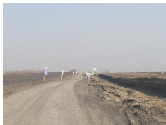
图 4.3-8 施工便道限行环保桩
