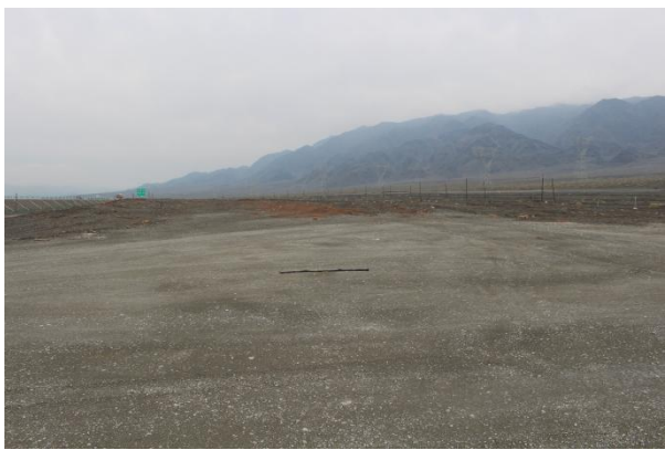
图4.1-15 施工生产生活区土地平整
