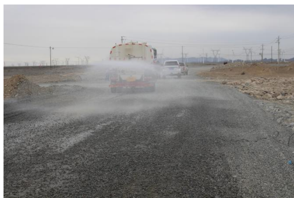
图 4.3-6 施工便道洒水
