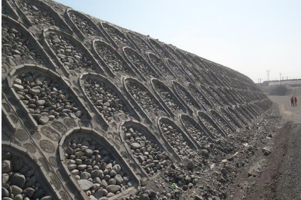
图4.1-2 路基边坡砌石卵石护坡
