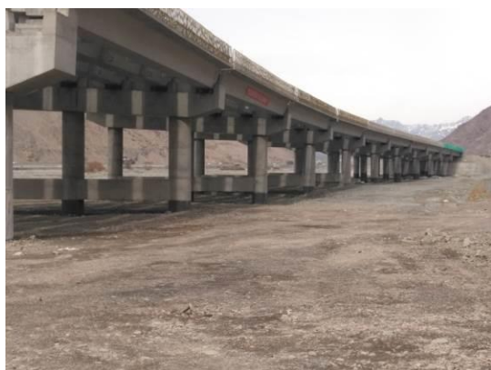
图4.1-9 桥梁工程土地平整
