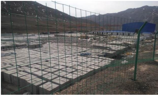
图 4.3-1 施工生产生活区铁丝网围挡
