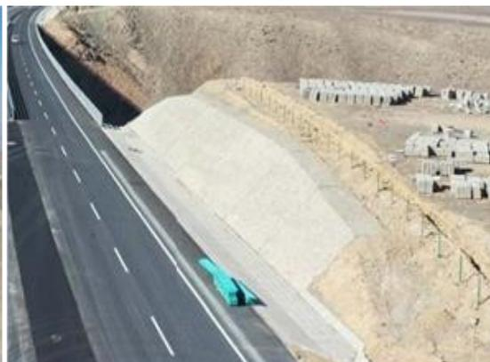
图 5.5-1 (4) 路基防护工程（护面墙）
