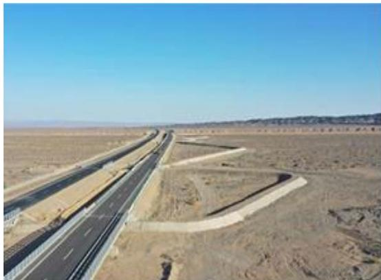
图 5.5-1 (1) 路基防护工程（导流坝）
