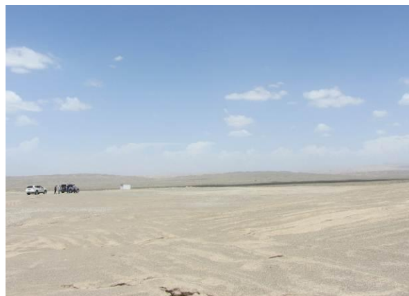
K7+000处临时场地平整（2018年8月）
