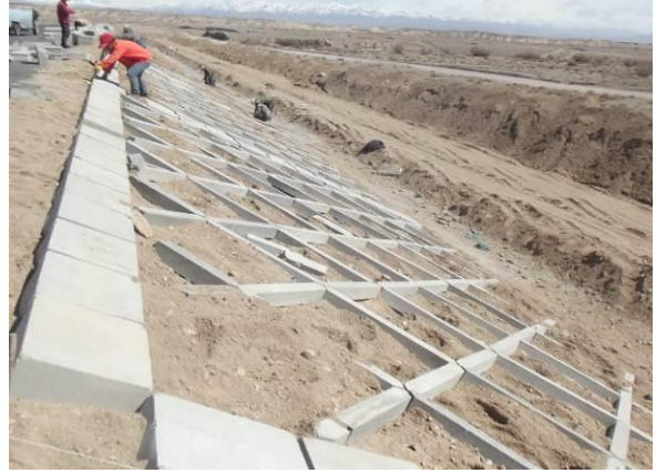
主体工程区菱形骨架护坡（2017 年 8 月）
