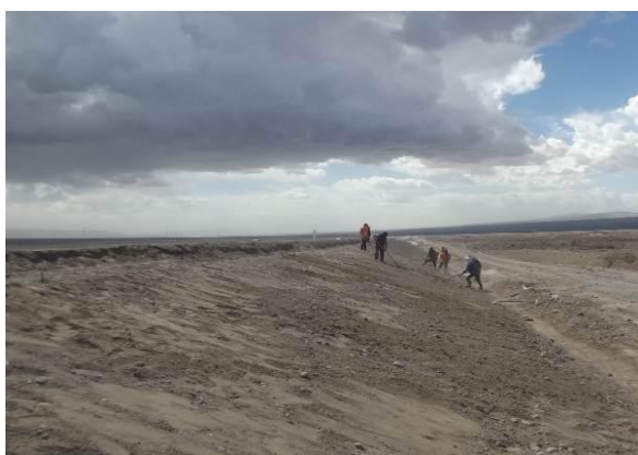
K42+800 处路基现状（2016 年 11 月）
