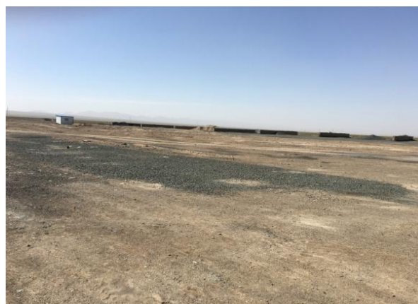
K16+400临时场地平整（2018年11月）
