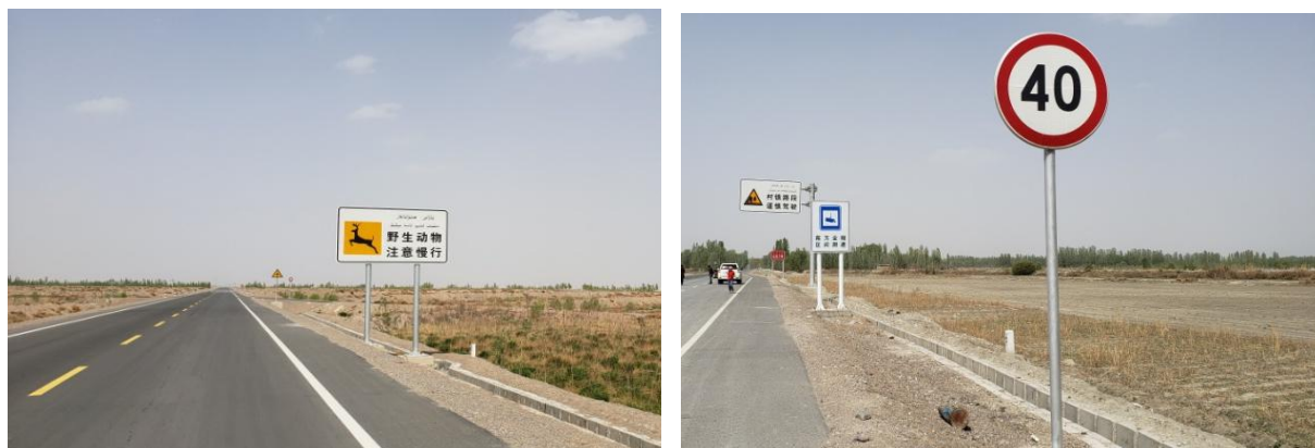
起点、终点路段路基边坡防护工程和排水工程
