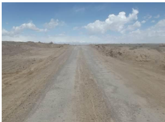
K107+000 处施工便道现状 (2017 年 4 月)
