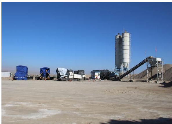
K7+000处修建临时场地（2016年11月）
