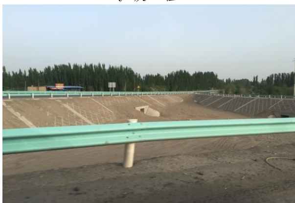
立交平整及护坡工程
