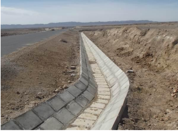
主体工程区排水沟（2017 年 4 月）
