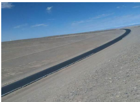
K15+300 处路基施工现状 (2017 年 9 月)
