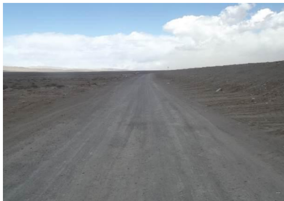
K16+000 处施工便道现状（2016 年 11 月）
