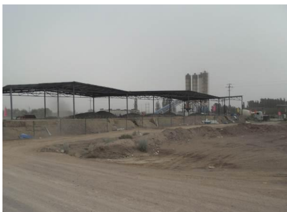
进场前2标临建场地修建完成
