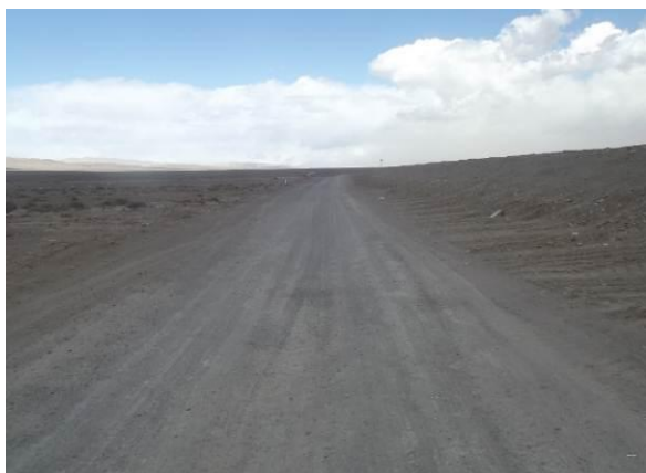
K16+000 处施工便道现状 (2017 年 4 月)
