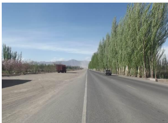
库车立交处路基现状 (2017 年 4 月)
