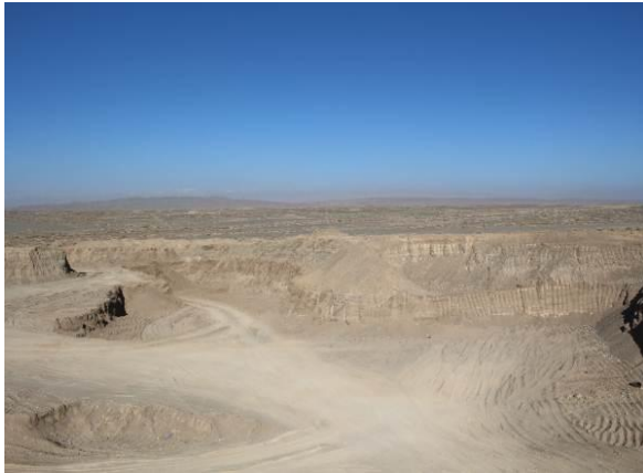
K6+000, 路基右侧 (2016 年 11 月)
