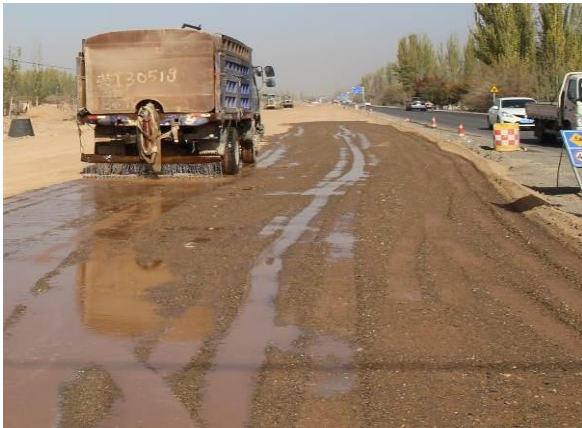
主体工程路基洒水(2016 年 8 月)
