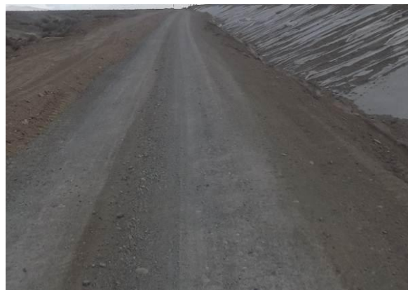
K16+000 处施工便道现状（2017 年 4 月）
