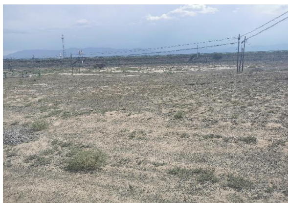
取弃土（料）场施工便道
