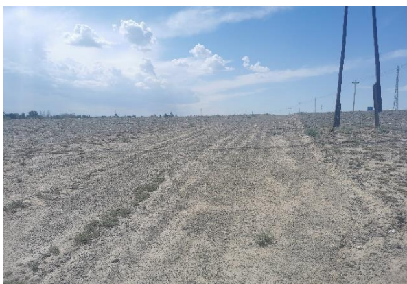
路基施工便道
