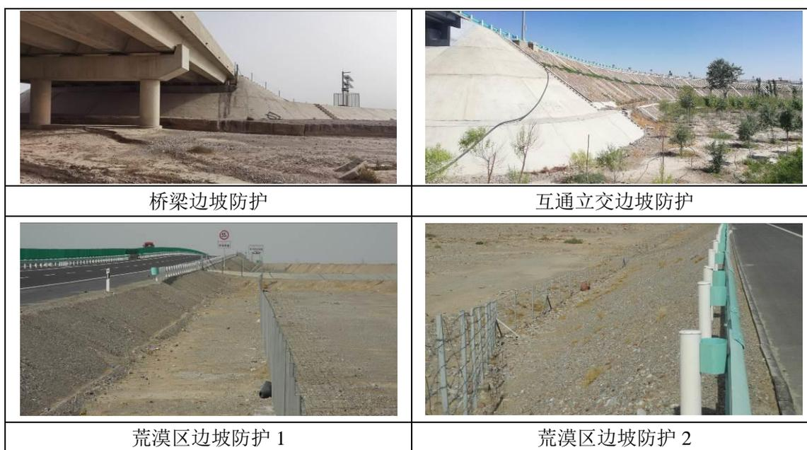
图 6.5-1 项目沿线边坡防护情况照片
