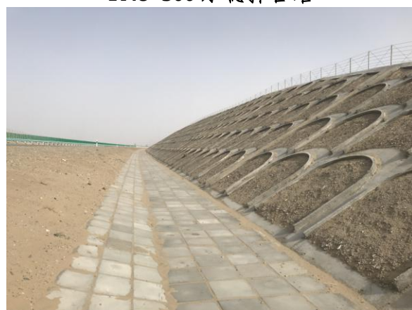
骨架护坡及排水沟
