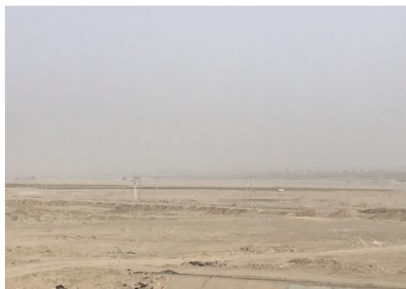
一标 K7+200 左侧取弃土场（恢复后）
