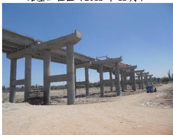
桥梁工程区 (2015 年 11 月)
