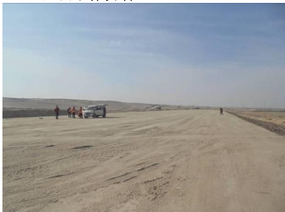
路基工程区 (2015 年 11 月)
