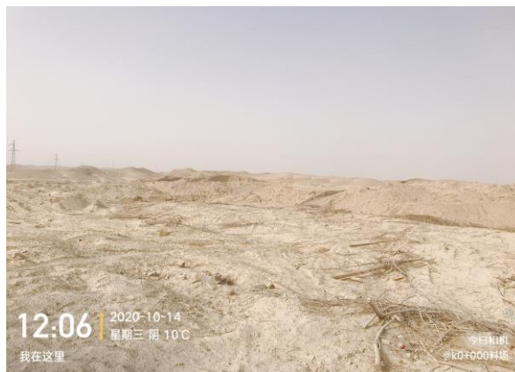
一标 K0+000 右侧取弃土场（恢复后）
