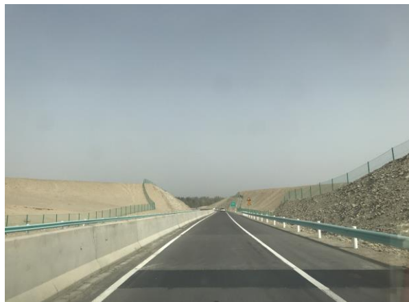
路基工程区 (2020 年 10 月)
