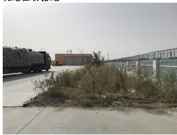
和田服务区附属设施植物措施
