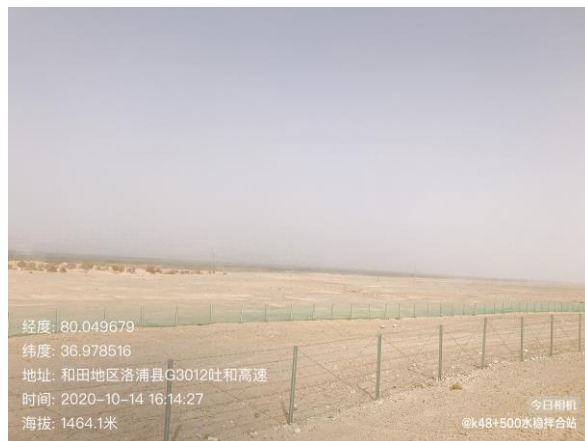
K48+500 水稳拌合站
