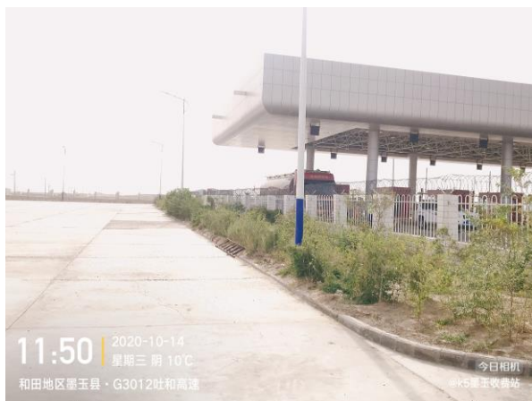
墨玉收费站附属设施植物措施
