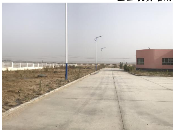
墨玉收费站附属设施植物措施
