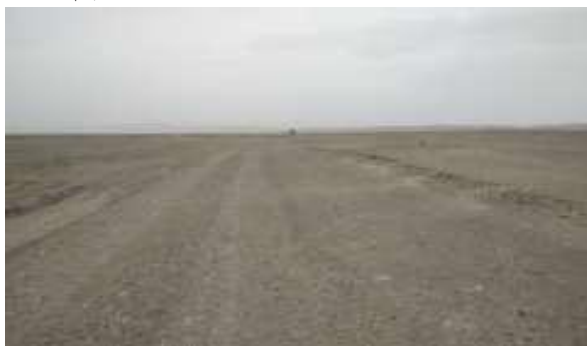
横向施工便道现状(K68+100取弃土场)
