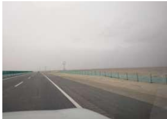
填方边坡自然坡面
