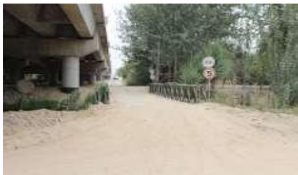
纵向施工便道现状
