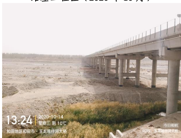
桥梁工程区 (2020 年 10 月)
