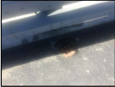
桥面收集系统排水孔
