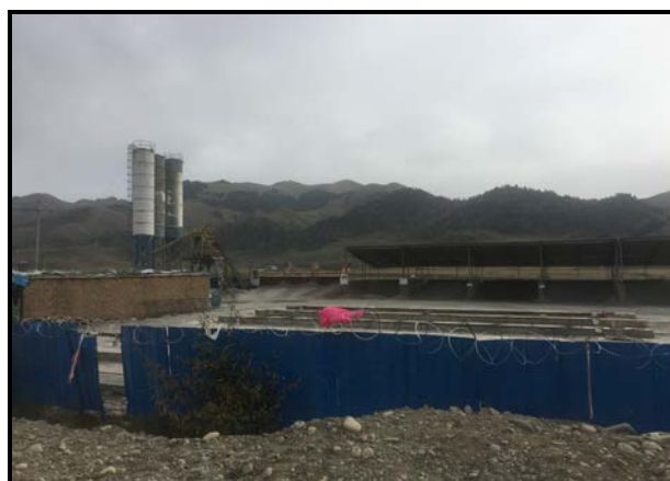
搅拌站篷布遮挡
