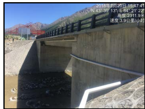
K0+230 桥面径流桥面排水收集系统
