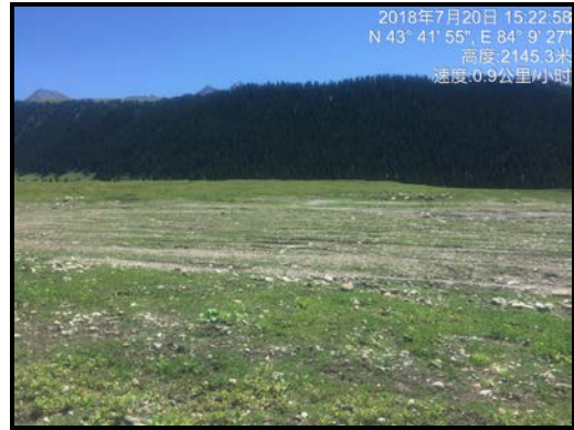
K17+600 左侧弃土场恢复情况
