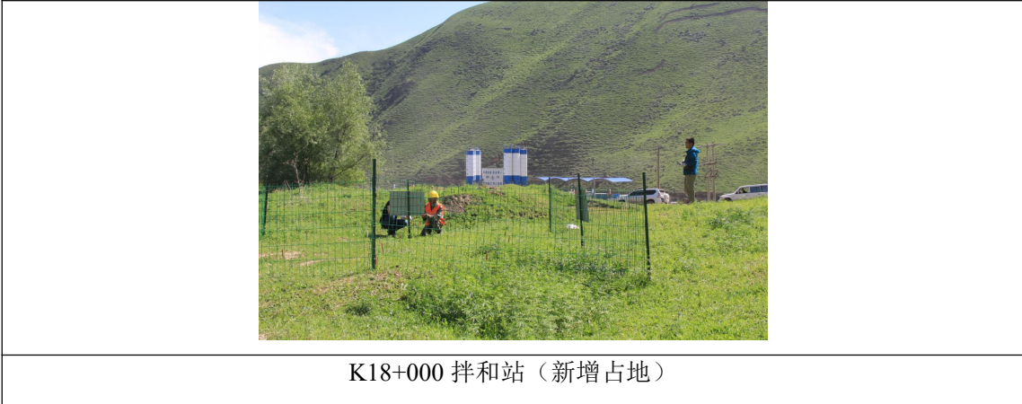
图 3.4-1 施工生产生活区布设情况
