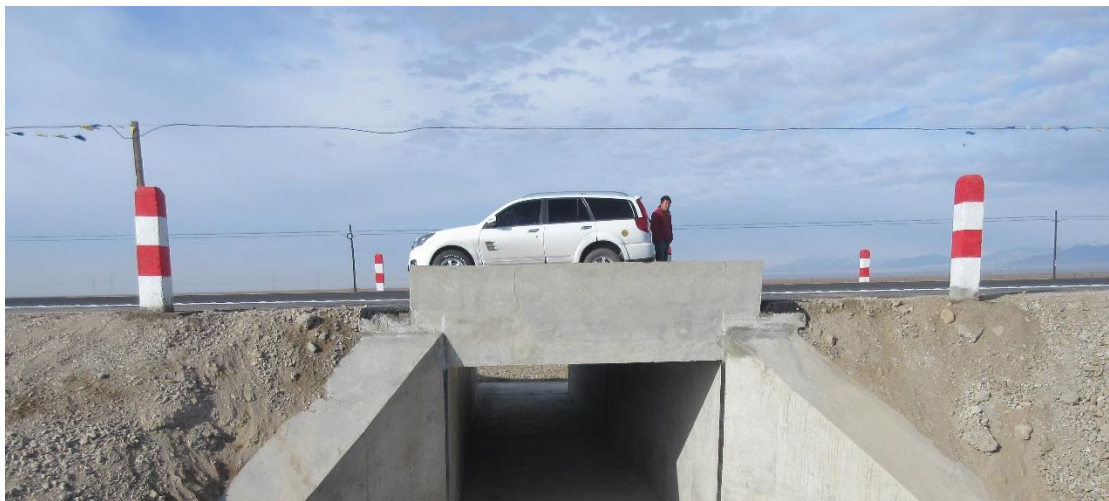
图 11.2-1 K16+950 处火箭农场供水水渠的防撞护栏和防撞墩
