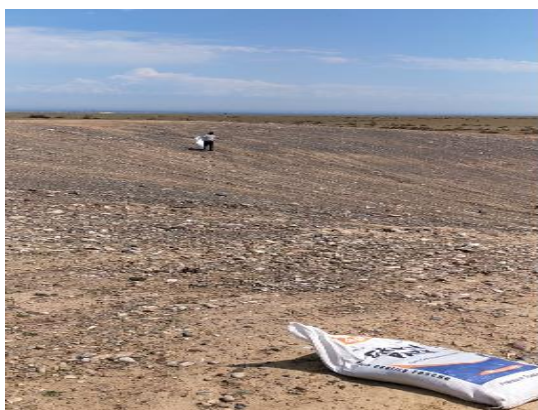
K11+750 左侧 500m 取土料场撒播草籽
