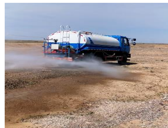
K23+700 左侧 800m 取土料场洒水
