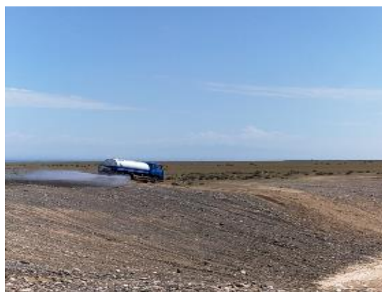
K11+750 左侧 500m 取土料场洒水
