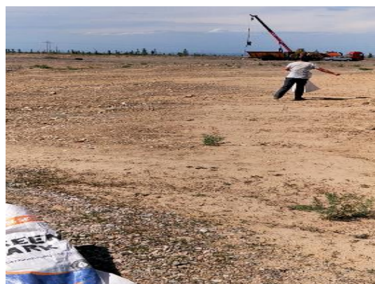
K23+700 左侧 800m 取土料场撒播草籽
