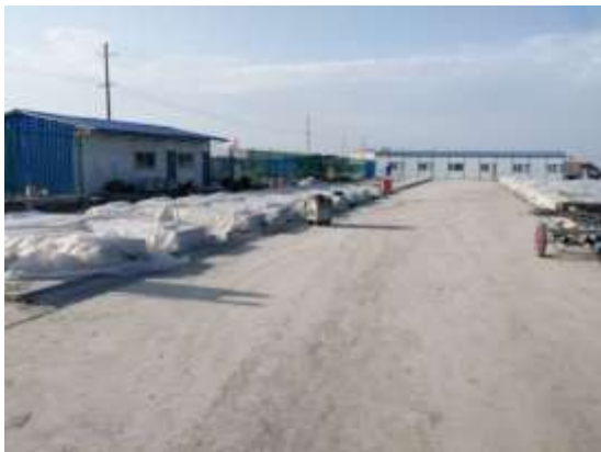
图 4.3-5 施工生产区防尘网苫盖
