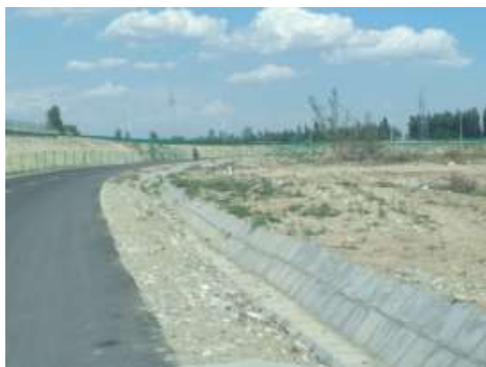
图 4.1-2 路基区路基排水工程
