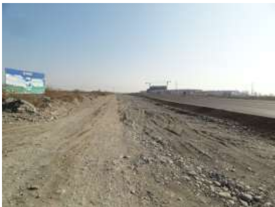
图 4.1-8 K0-K0+300 左侧施工便道土地平整
