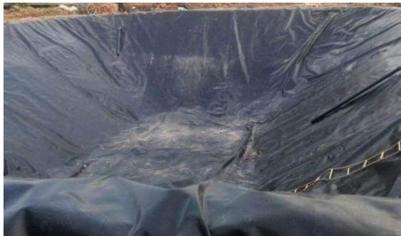
图5.5-1 聚乙烯18丝防渗膜现场施工图
