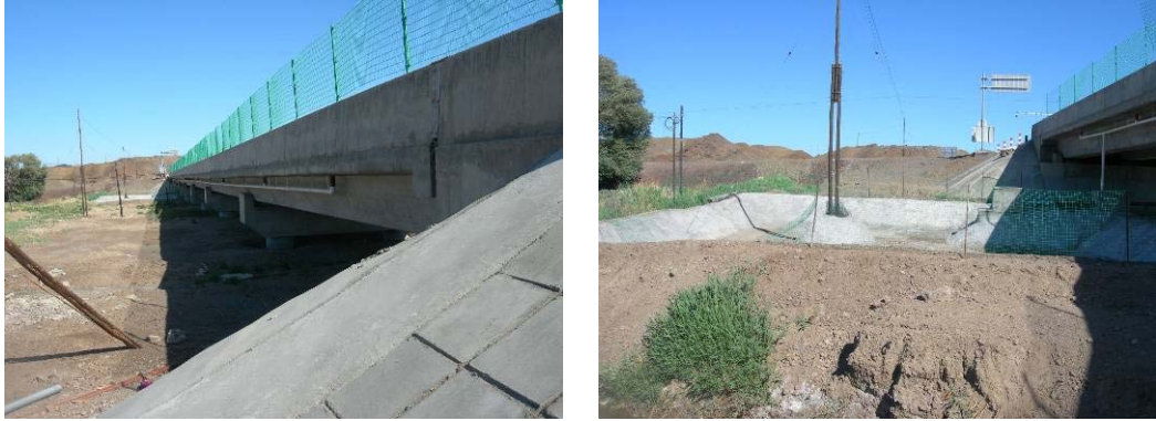
图7.3-2 三塘湖大桥的桥面径流收集系统照片
