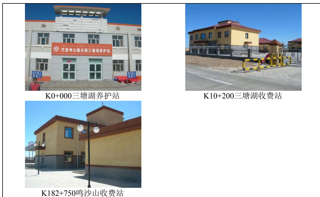
图 2.4-2 公路沿线服务设施现场图
